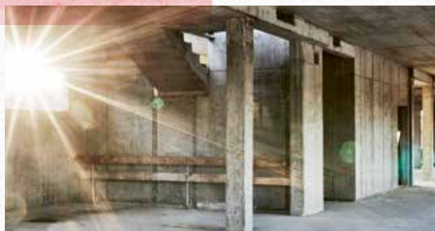
Noch Baustelle, schon bald das Zuhause für 240 Elektrobusse.
